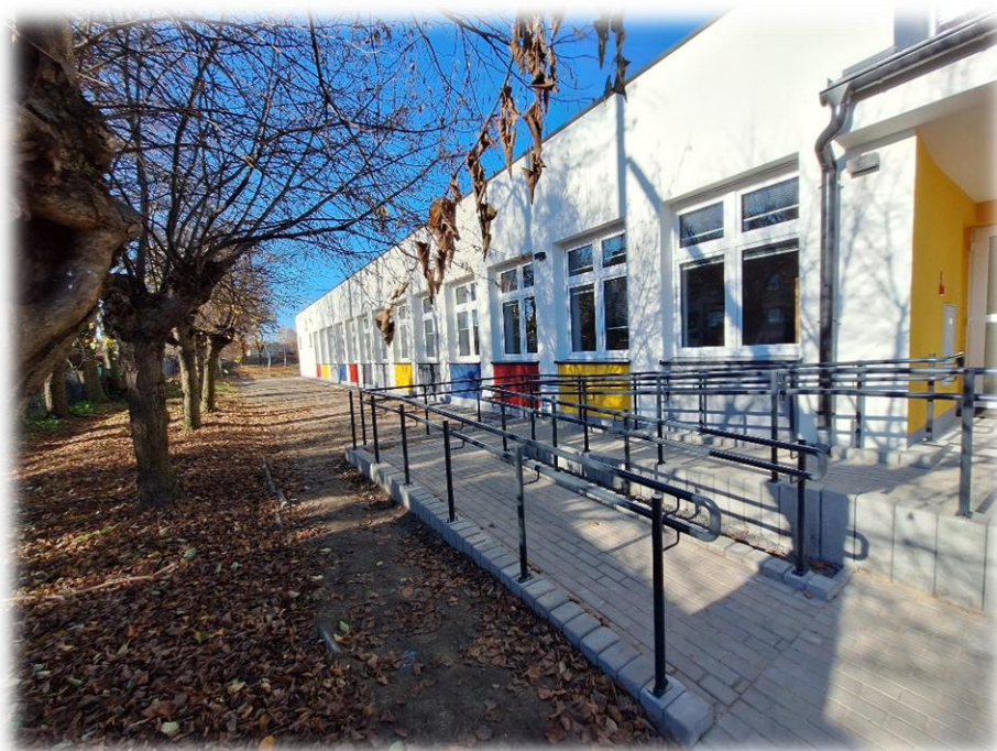
Ryc. 13 Inwestycja termomodernizacyjna budynku szkolnego w Nieparcie
