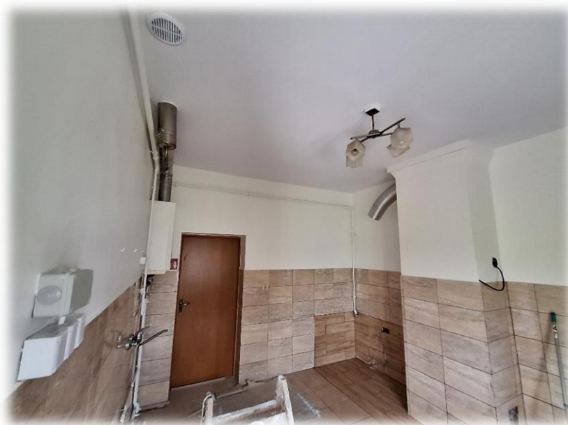
Ryc. 28 Prace w pomieszczeniu kuchennym świetlicy w Przyborowie
