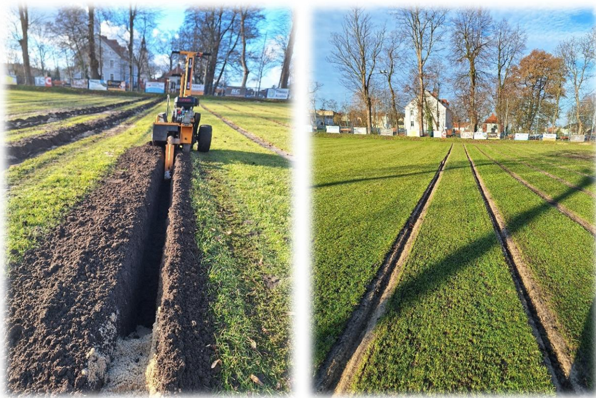
Ryc. 37 Boisko sportowe w Krobi w trakcie modernizacji
