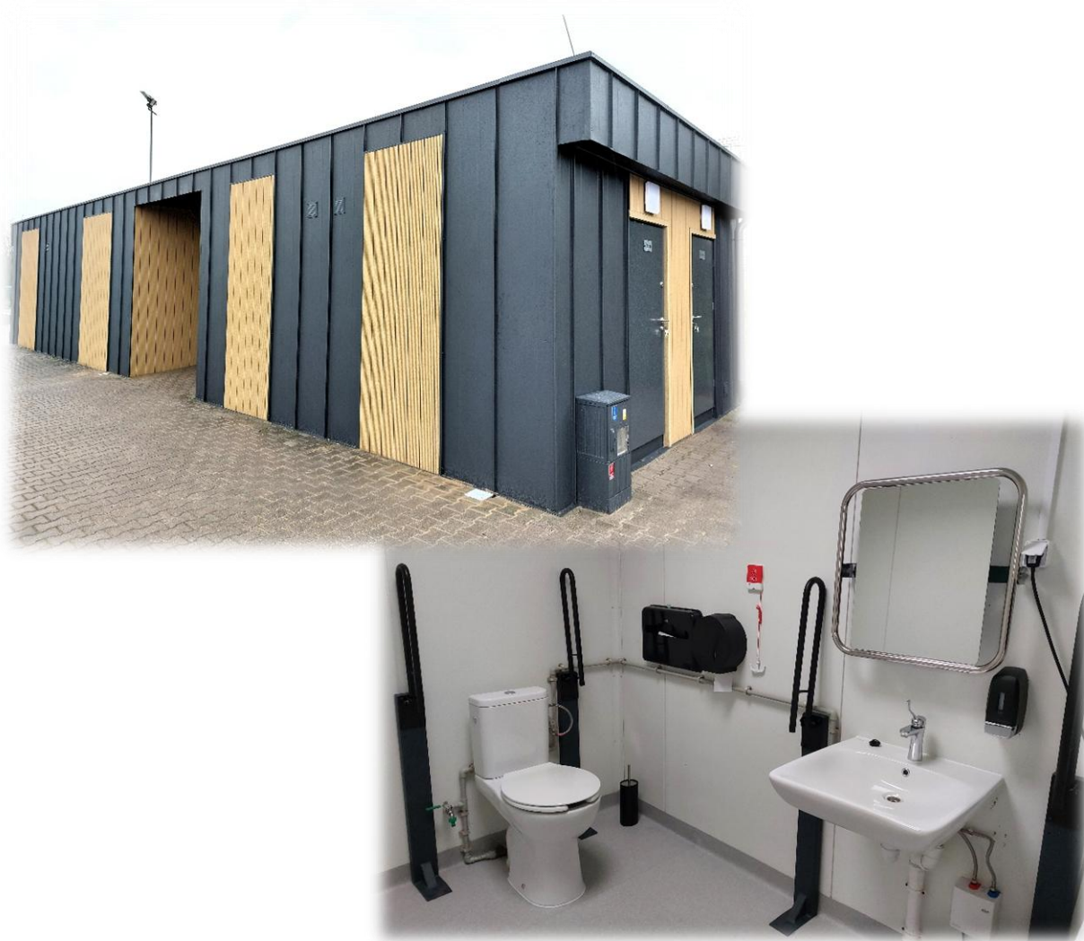
Ryc. 10 Zmodernizowana szatnia przy „Orliku” w Krobi
