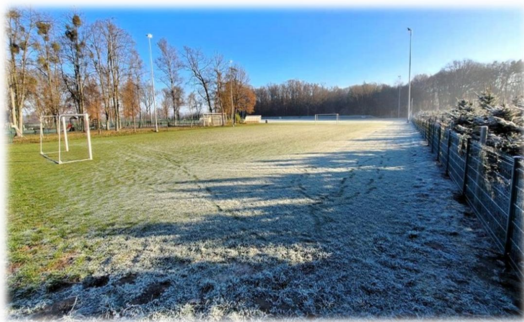
Ryc. 35 Boisko sportowe w Chwałkowie z nowym ogrodzeniem
