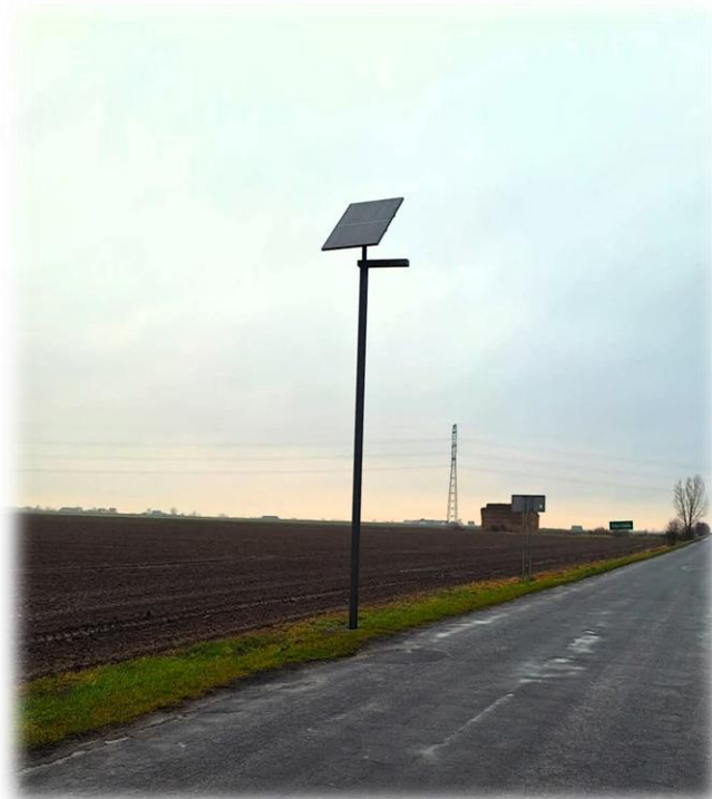
Ryc. 21 Lampa solarna przy jednej z dróg na terenie gminy Krobia
