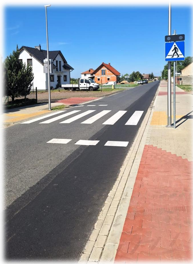
Ryc. 24 Ścieżka rowerowa od drogi wojewódzkiej nr 434 do miejscowości Chumiętki
