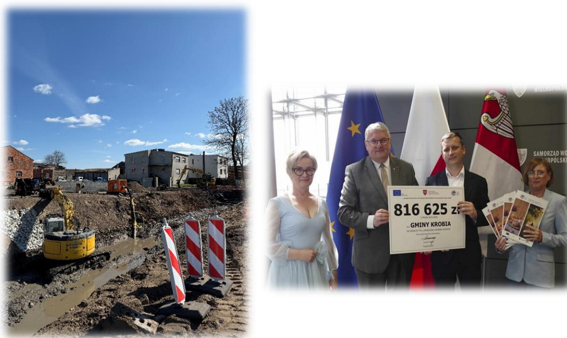
Ryc. 76 Przebudowa stawów na terenie gminy w ramach uzyskanego przez Gminę Krobia dofinansowania
