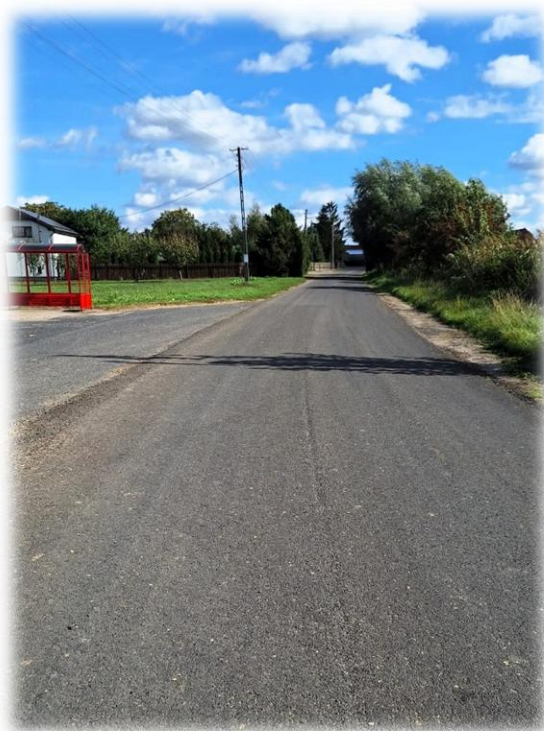
Ryc. 20 Nowa nawierzchnia drogi gminnej Kuczyna – Ziemlin
