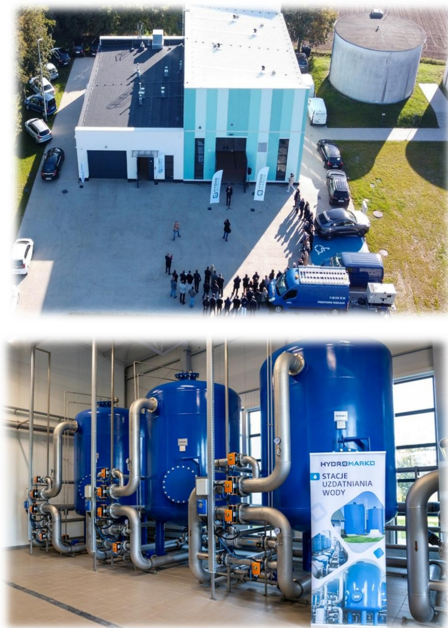
Ryc. 32 Stacji uzdatniania wody w Bukownicy
