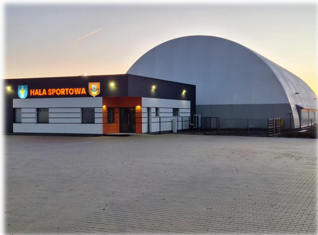
Ryc. 27 Hala sportowa w Gostkowie (zdjęcie po zakończeniu inwestycji, IV 2025 r.)
