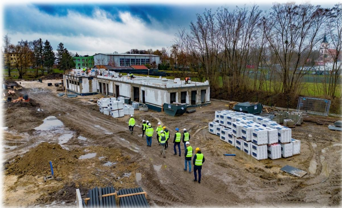
Ryc. 12 Plac budowy w miejscu powstawania stadionu sportowego przy ulicy Sportowej w Krobi
