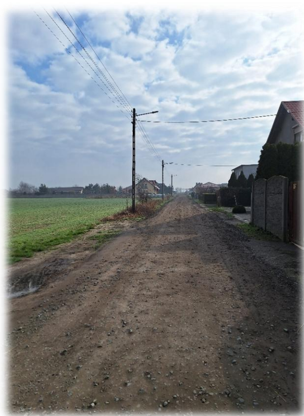
Ryc. 22 Obecny stan ulicy Wiosennej w Krobi
